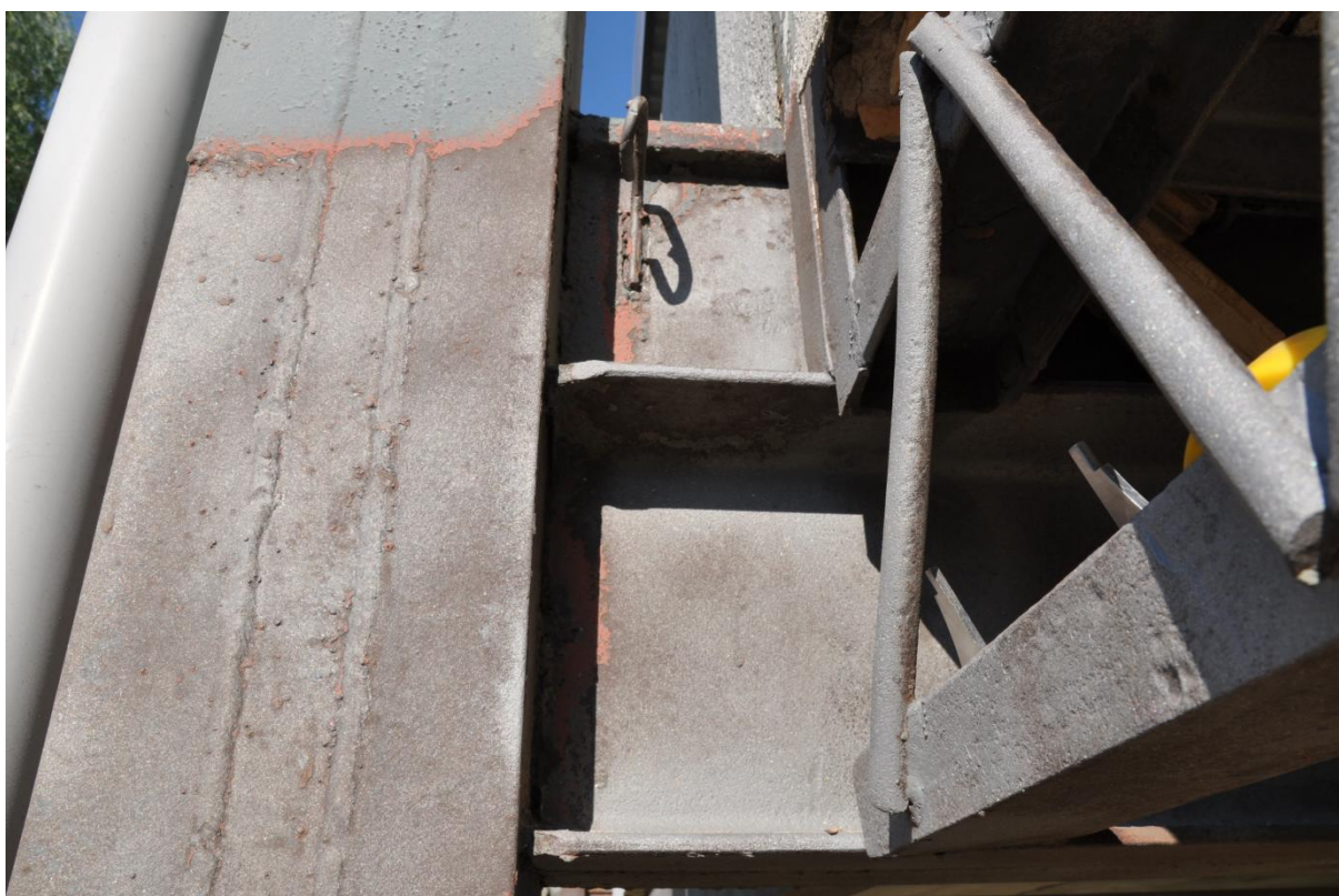
Fot. 4 Zamocowanie rygła głównego do słupa
