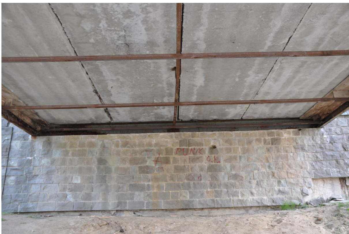
Fot. 8 Układ płyt kanałowych w przęśle pierwszym
