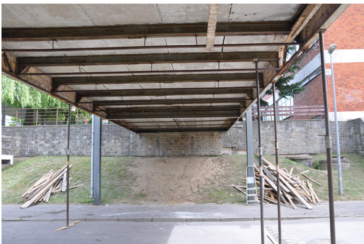
Fot. 9 Układ płyt kanałowych w przęśle drugim (nad przejazdem)
