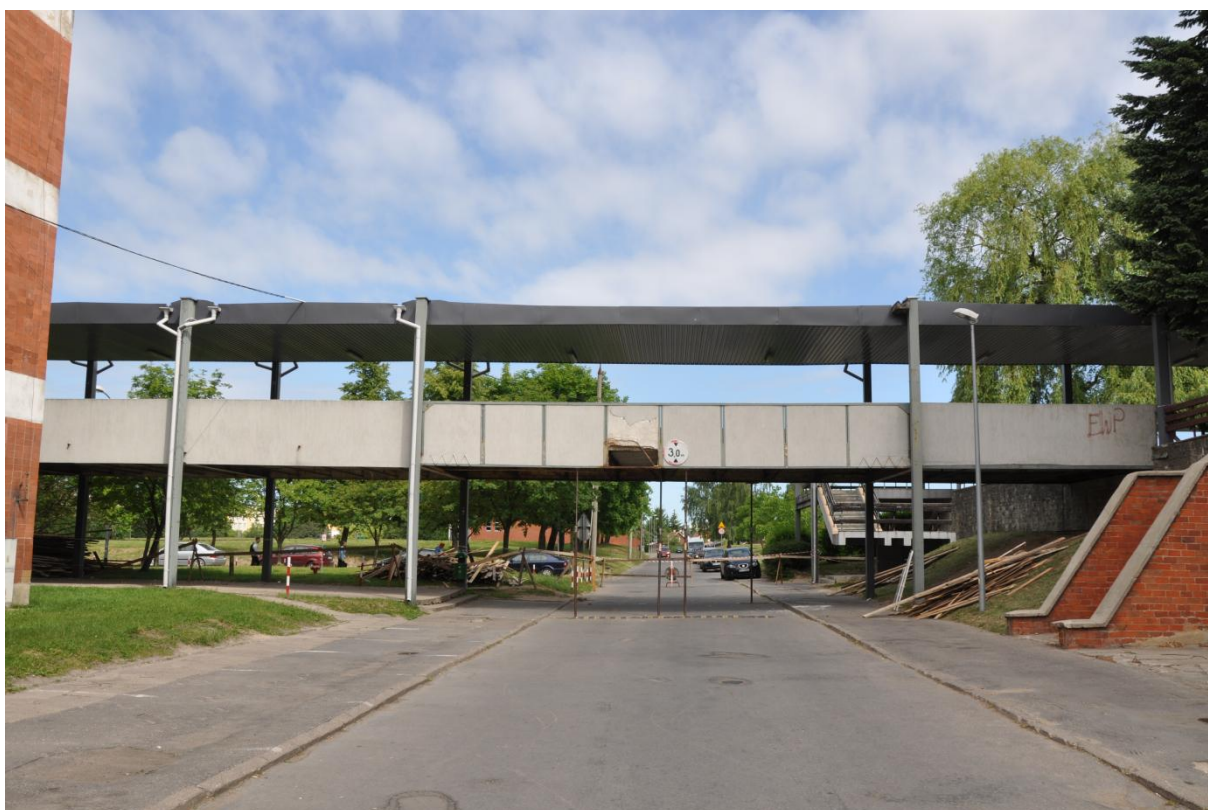
Fot. 1 Widok ogólny ciągu komunikacyjnego
