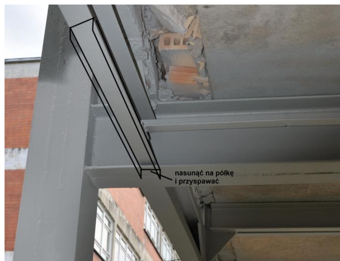
Fot. 6-1 Zamocowanie dodatkowego pasa wzmacniającego z C50 między osiami 2' i 3'
