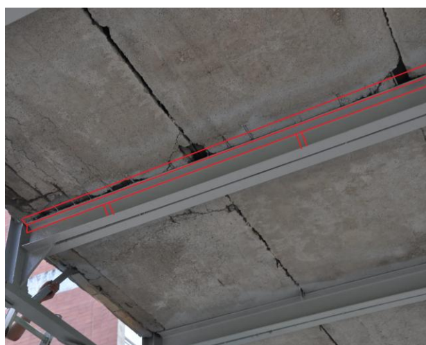
Fot. 6-6 Dodatkowe podparcie płyt stropowych w osi f
