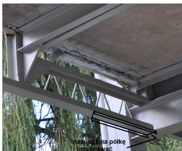
Fot. 6-2 Zamocowanie dodatkowego pasa wzmacniającego z C100 między osiami 1' i 2'
