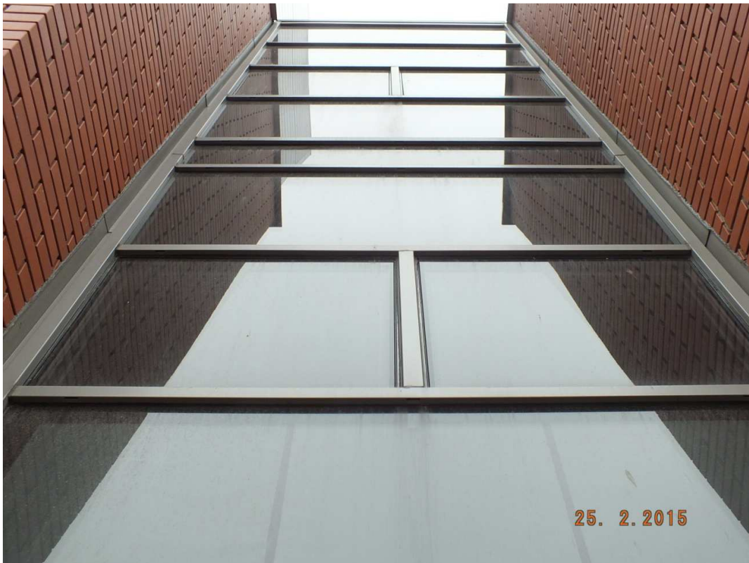
Zdjęcie nr 3. Widok na fasadę – zbliżenie połączenia z murem z cegły klinkierowej.
