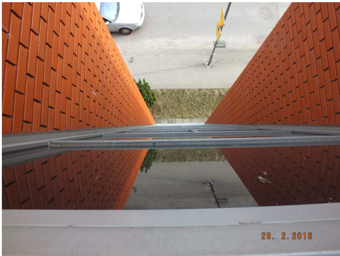
Zdjęcie nr 8. Widok na fasadę z dachu.
