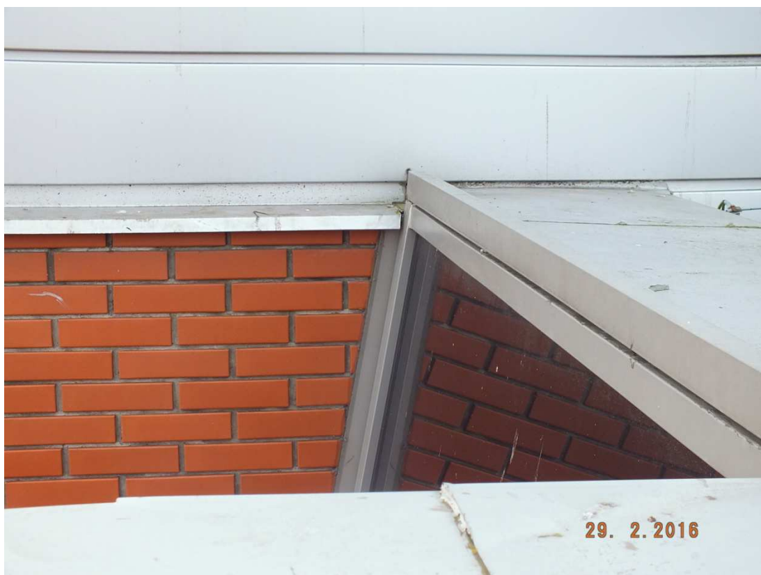
Zdjęcie nr 9. Widok na fasadę z dachu – połączenie zakończenia górnego przeszklienia.
