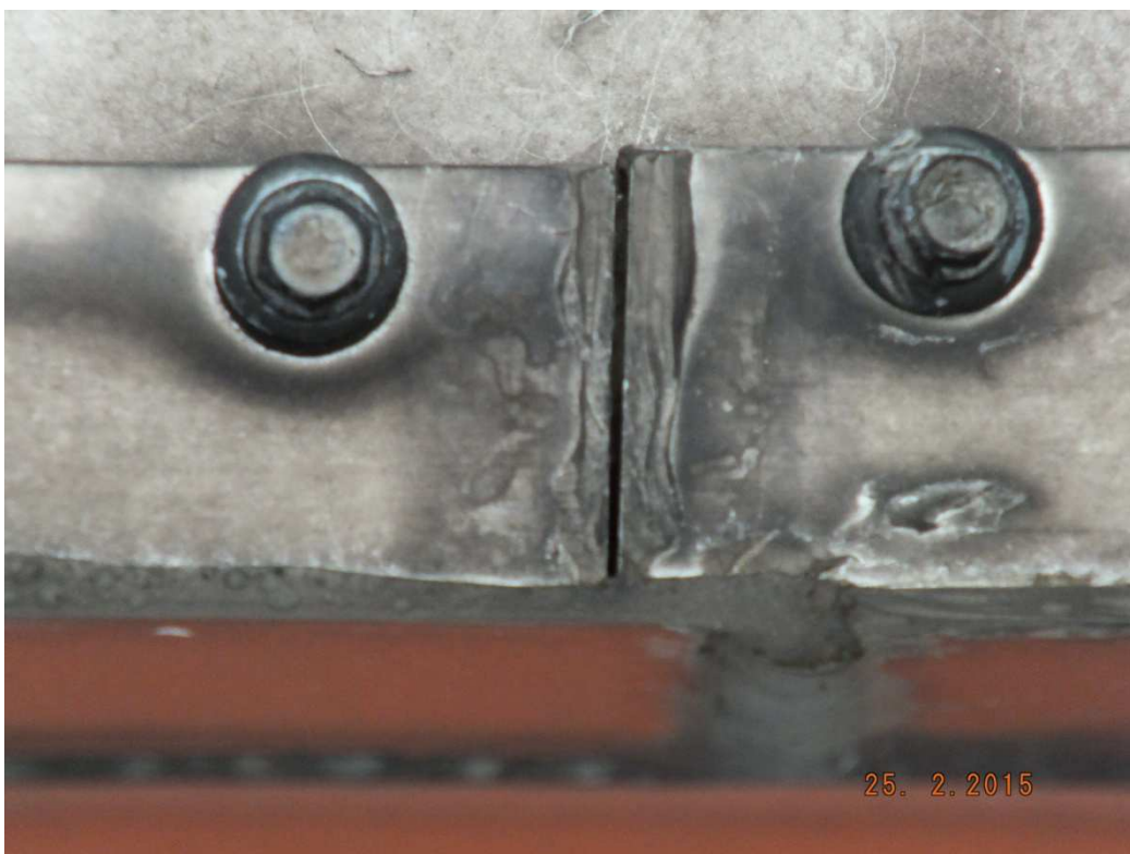
Zdjęcie nr 10. Widok szczegółu miejsca połączenia elementów kasety z blachy nad oknami III piętra.
