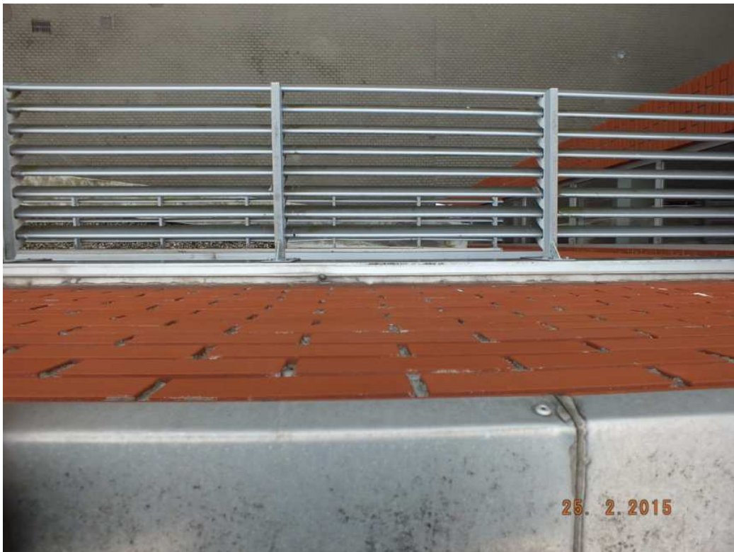
Zdjęcie nr 10. Widok szczegółu miejsca połączenia elementów kasety z blachy nad oknami III piętra.
