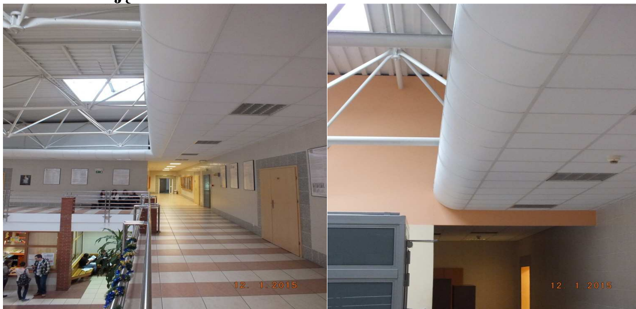
Widok na sufit podwieszany w Głównym Holu Hali nad komunikacją antresoli. Zdjęcie 10 i 11.
